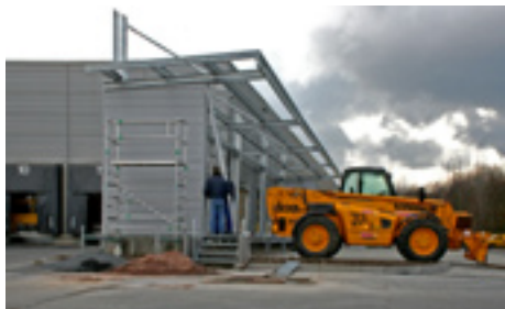
Mehr Rampen und Tore: Die Zusatzmodule im Postverteilzentrum in der Siekhöhenallee werden montiert.
